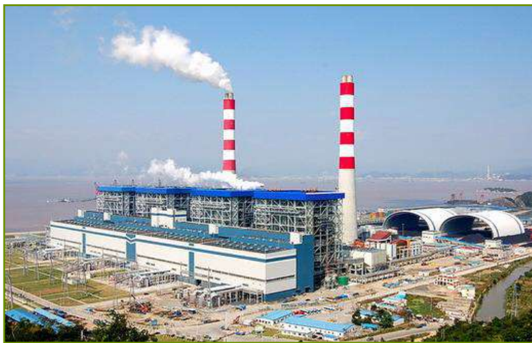
建成了世界最大的复合塔脱硫工程 华能玉环电厂一期2×1000MW机组
