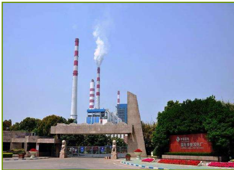
建成世界单机容量最大的1000MW级全负荷脱硝工程 国电江苏谏壁发电有限公司
